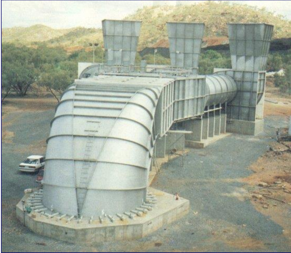
Figura 2: Ventiladores tipo Centrifugo
